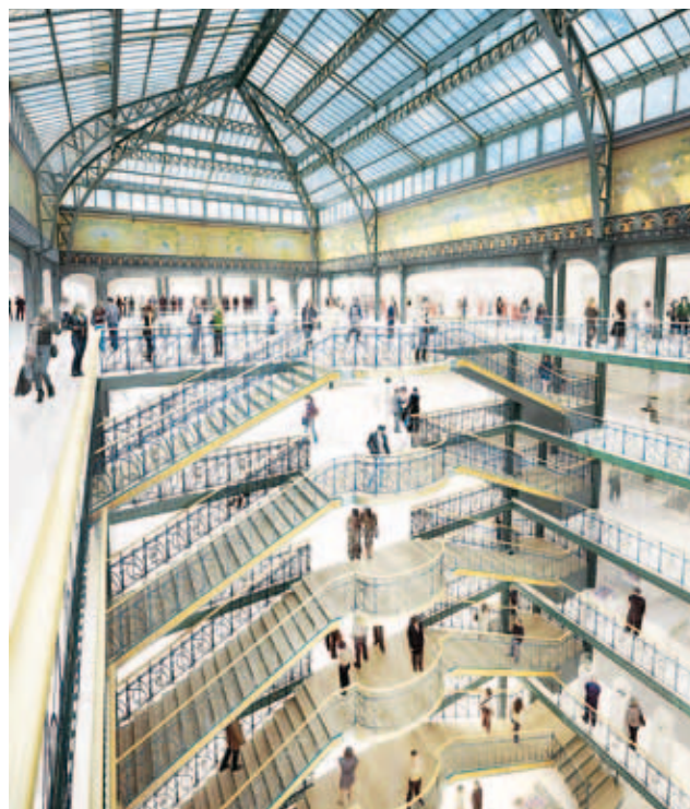
La grande verrière retrouvera son aspect original de 1907 et l'escalier monumental sera restitué à l'identique.
